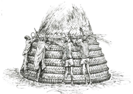
Fabrication d'un toit traditionnel
